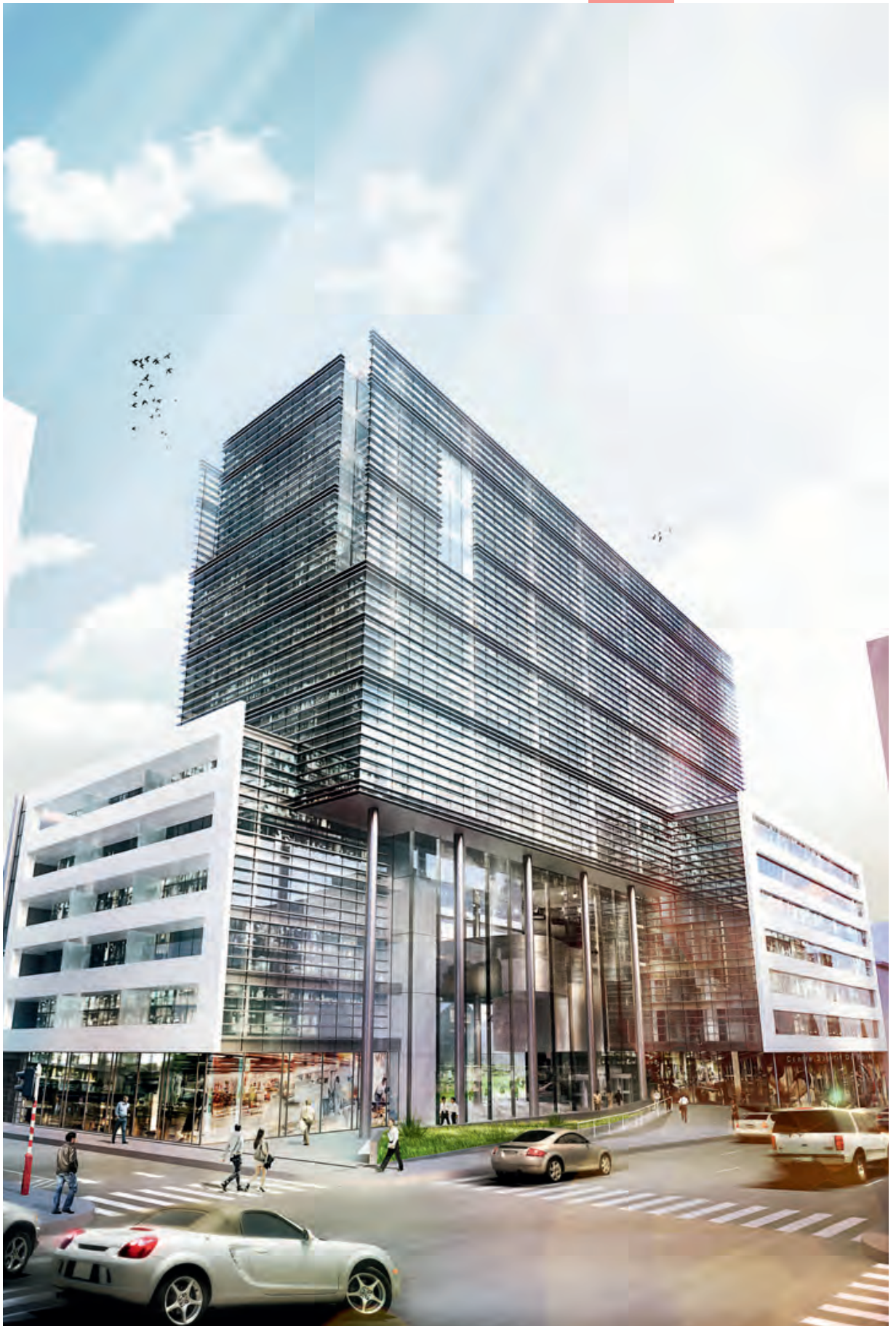
Science 15-17 - Bruxelles (après travaux : situation projetée)
