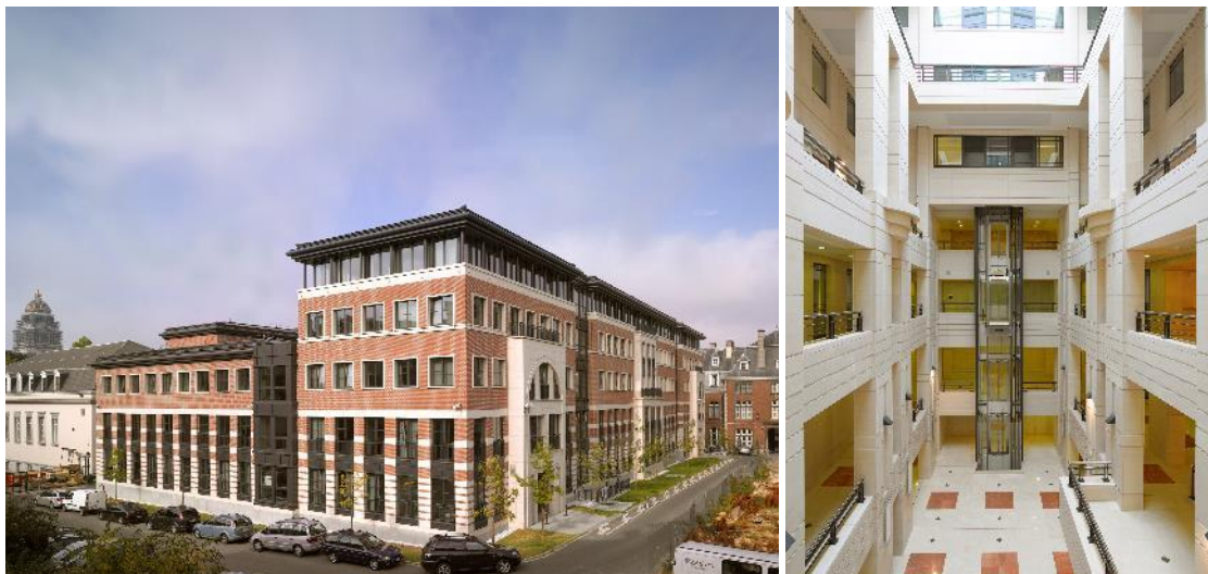
Immeuble de bureaux Egmont II – Bruxelles Centre
