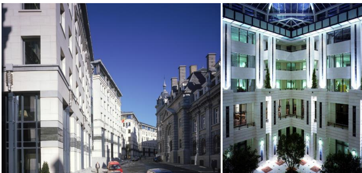
Immeuble de bureaux Egmont I – Bruxelles Centre
