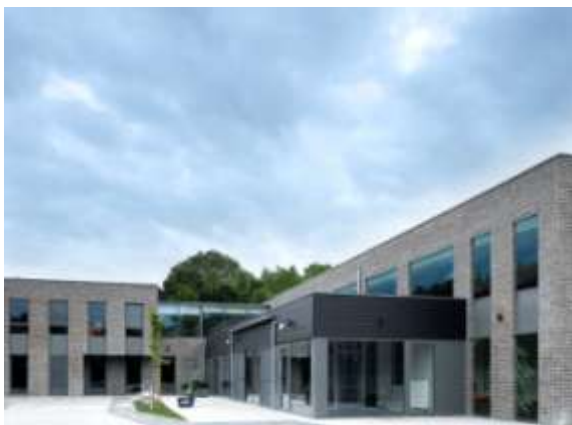
Maison de repos Noordduin - Coxyde
