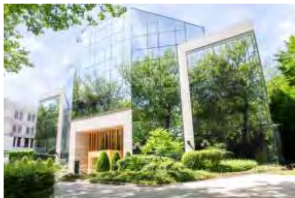
Immeuble de bureaux Souverain 24 – Bruxelles (BE)
