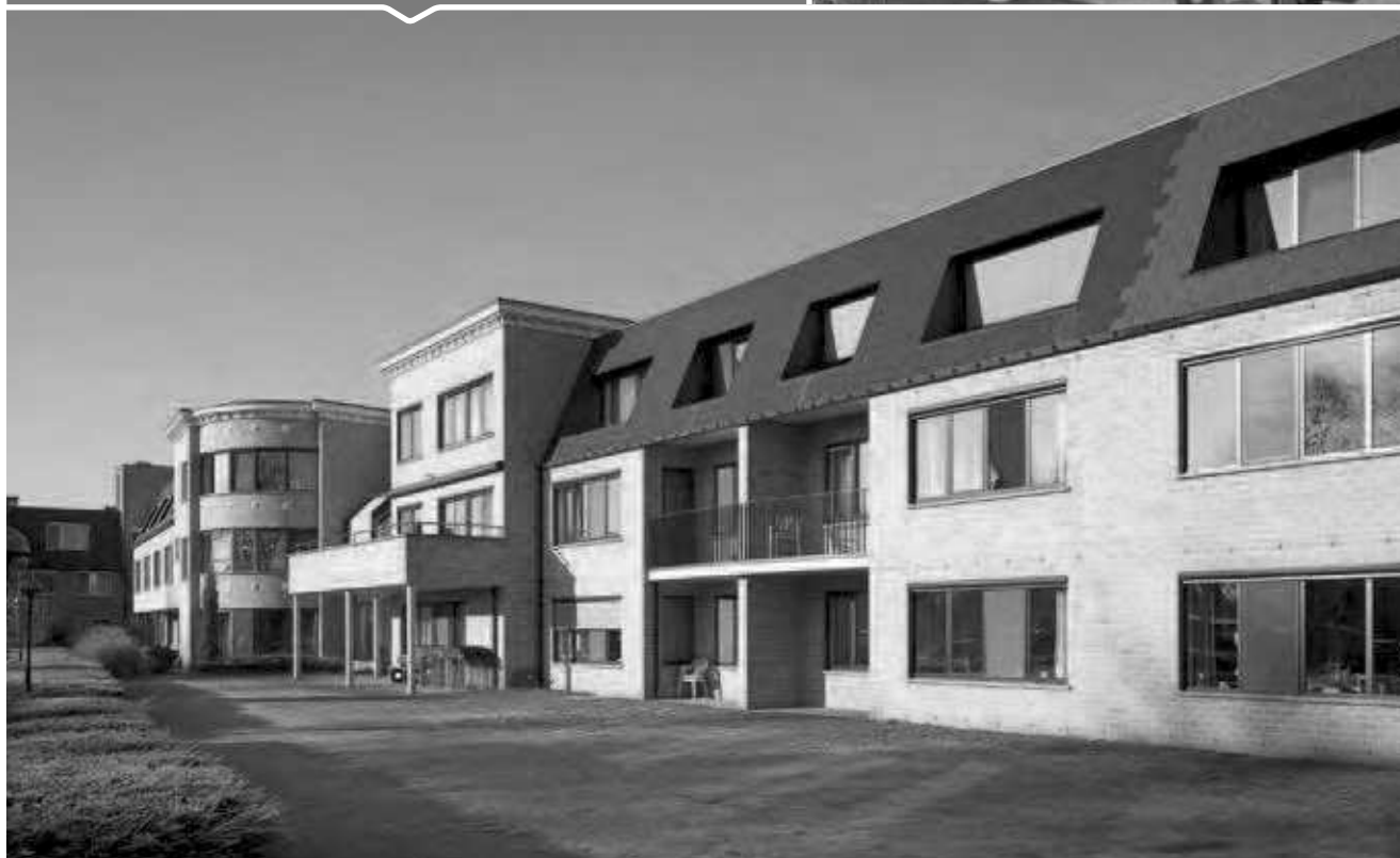
Maison de repos et de soins et résidences-services Laarsveld - Geel (BE)
