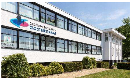
Oosterstraat medical office building – Baarn (NL)
