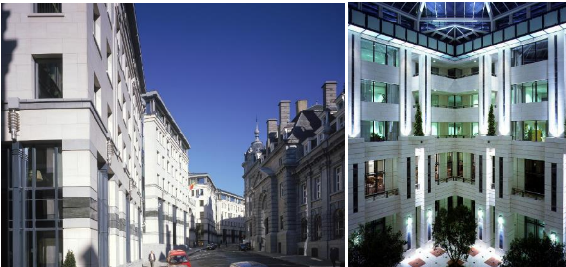
Kantoorgebouw Egmont I – Brussel Centrum
