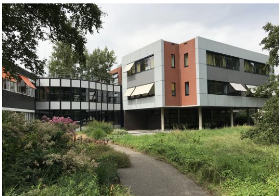
Situation actuelle avant travaux
