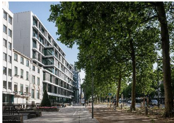
Quartz kantoorgebouw Central Business District van Brussel (België) BREEAM Excellent
