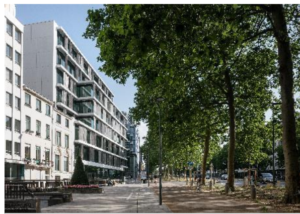
Kontorsfastighet Quartz Centrala affärsdistriktet Bryssel (Belgien) BREEAM Excellent
