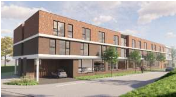
Maison de repos et de soins Villa Batavia – Grimbergen (BE)
