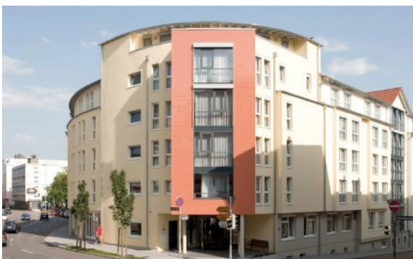
Maison de repos et de soins Haus Osterfeld – Pforzheim
