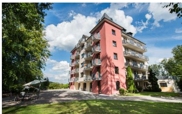
Maison de repos et de soins Parkhöhe – Lindenfels
