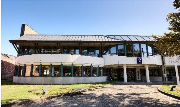
Maire 19 office building – Tournai/Doornik
